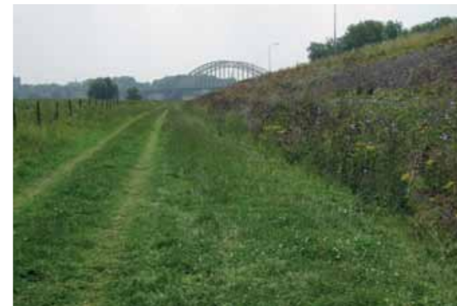
Beheerpad aan de onderzijde van de dijk
